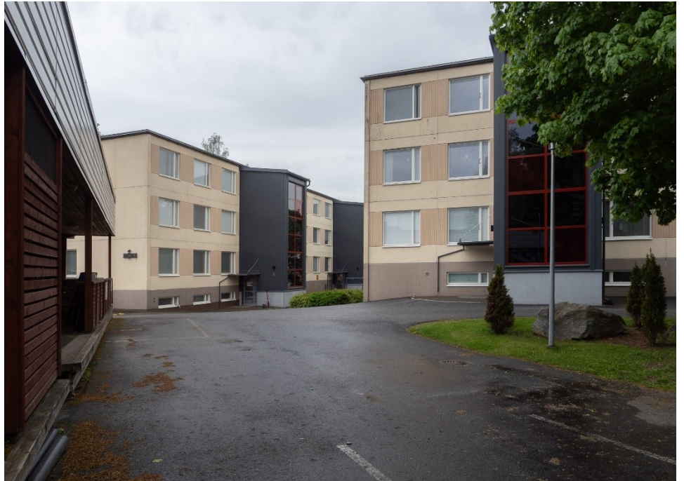
Kuva 4. Liikekiinteistön takaosa (vasemmalla) tontilla 5, pysäköintipaikkoja, tontin sisäistä ajoaluetta sekä istutuksia. Kuvan asuinkerrostaloihin tontilla 6 on toteutettu rakennusmassasta ulkonevat porraskuilut vuonna 2016. Pekko Sangi 2025.
